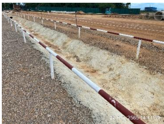
รูปที่ 3.1-27 รางระบายน้ำภายในพื้นที่โครงการ
